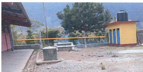
Foto 5: EN ESTA PARTE SE LE VA HACER MEJORAMIENTO DE MURO PÓRTICO CON UNA MEDICIÓN DE 11 METROS DE LARGO POR 2.50 METROS DE ANCHO.
