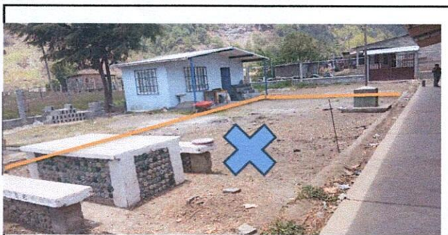
Foto 3: ESTA VISTA ESTA EN DIRECCION HACIA AL LADO NORTE, DONDE VA FINALIZAR EL ENTECHADO.
