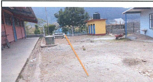
Foto 1: EL ENTECHADO INICIARÁ DESDE EL FONDO DEL MURO EN DIRECCION HACIA NORTE, CON UNA MEDICION DE 8 METROS DE ANCHO POR 19 METROS DE LARGO.
